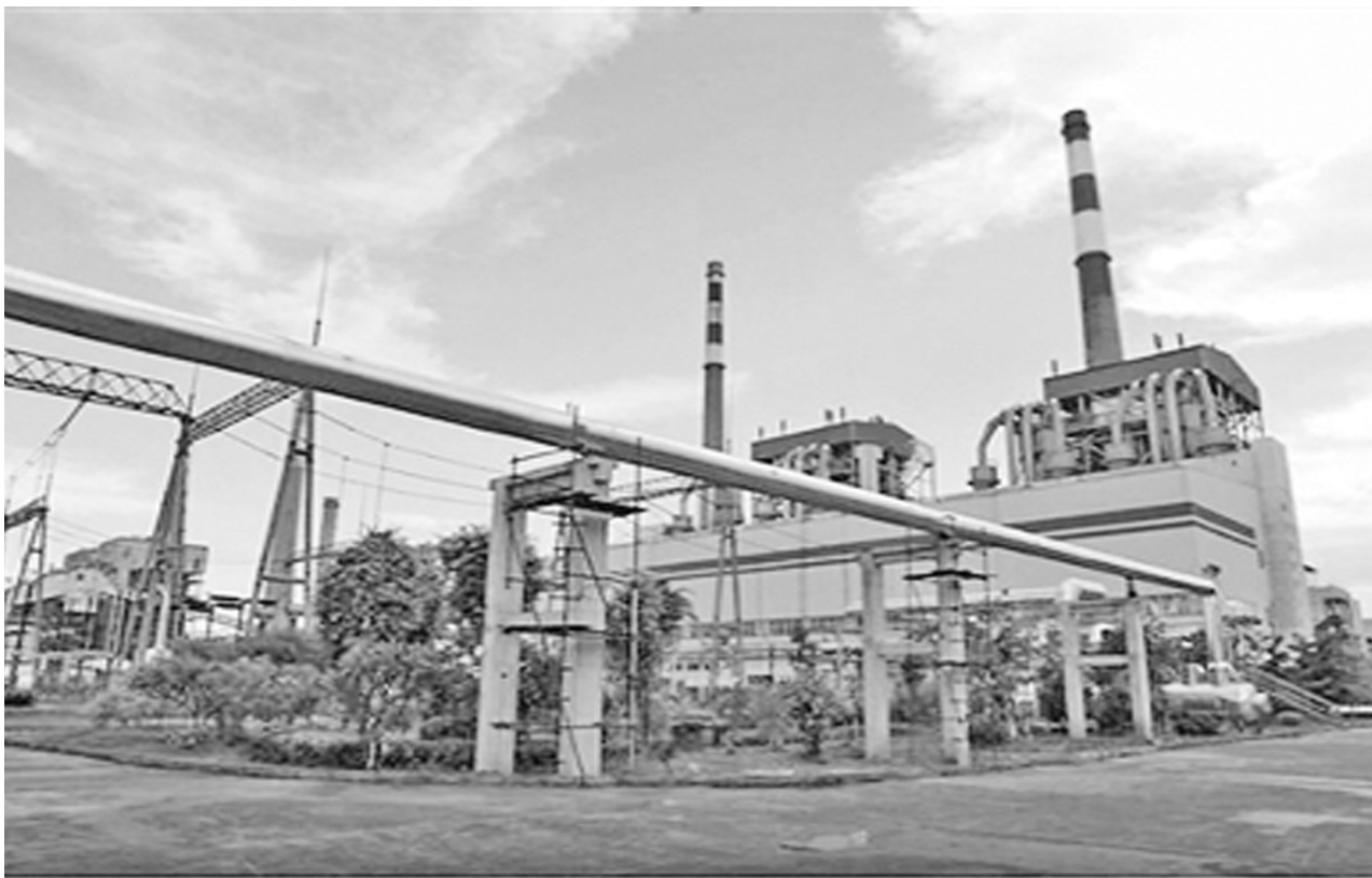
在来宾电厂热电联产的带动下,河南工业园区不仅实现了电的循环,还实现了其产业链的循环经济。图为来宾电厂厂区内供热管道。 资料图片
