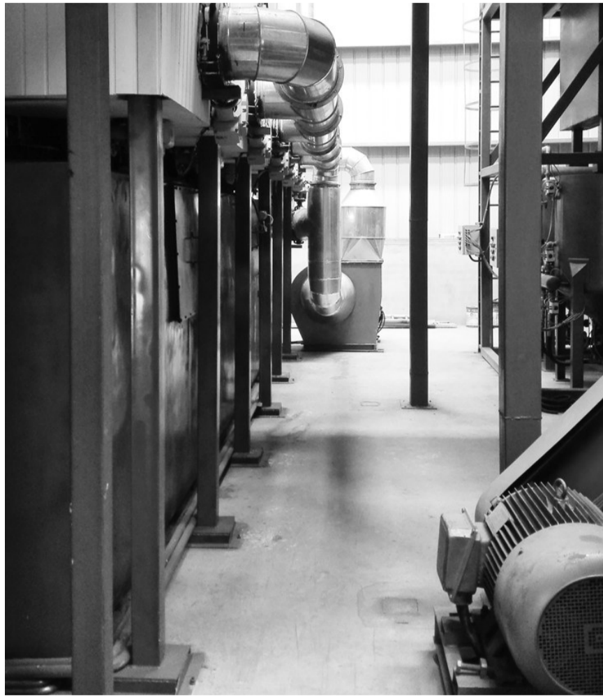
图为杭州彩虹环保技术工程公司研发的轮换式活性炭吸附-催化再生装置。
