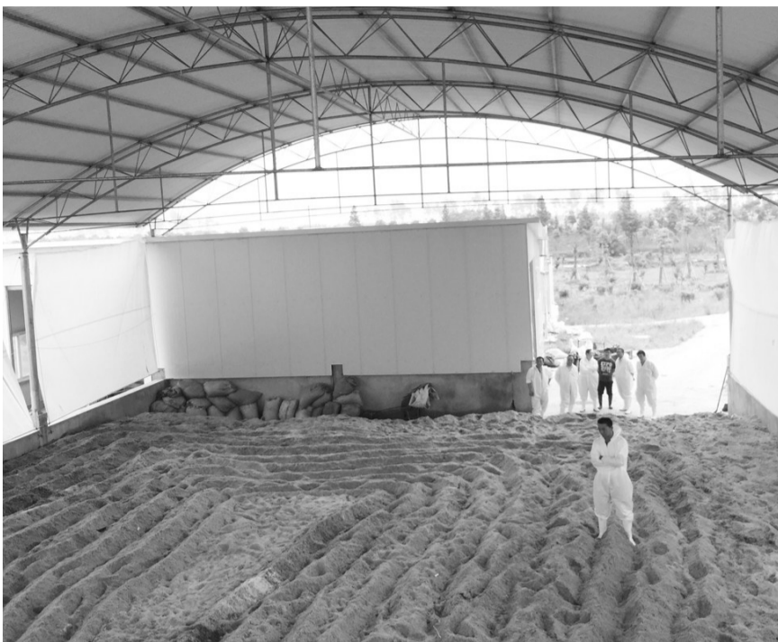
图为光明集团明锦猪场生物降解堆实景图。
