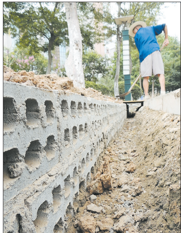
江苏省连云港市海绵城市示范区建设近日全面启动,优先考虑把雨水保留下来,自然积存、自然渗透、自然净化,或用于公园湖水补给、园林绿化灌溉等。图为工人在郁洲公园项目现场进行排水系统和透水砖改造。
