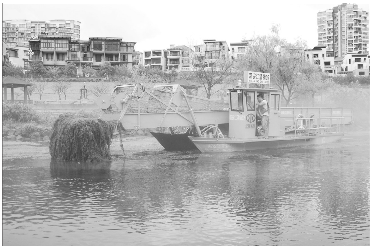
浙江省建德市近日开始对新安江主城区的洋安大桥至彩虹桥河道段水域,采用机械化船只割除水草,既减轻了工人的劳动强度,又提高了工作效率,起到了保护生态环境,确保水质安全的目的。 人民图片网供图
