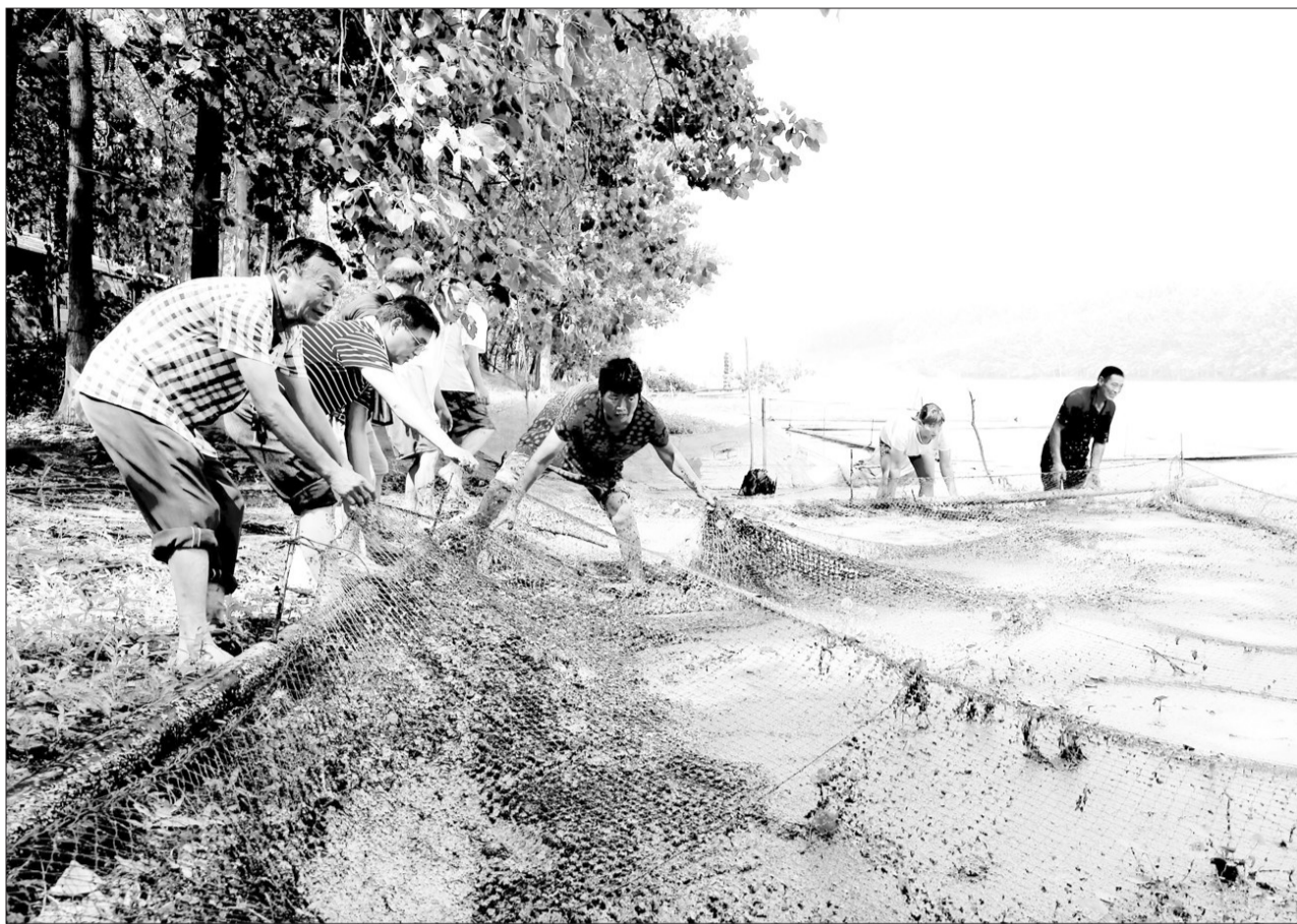
洪泽湖是南水北调的重要蓄水池之一。拥有洪泽湖40%水面的江苏省泗阳县,不定期组织人员对湖面以及北上输水河道进行清理,确保水质达标安全。人民图片网供图
