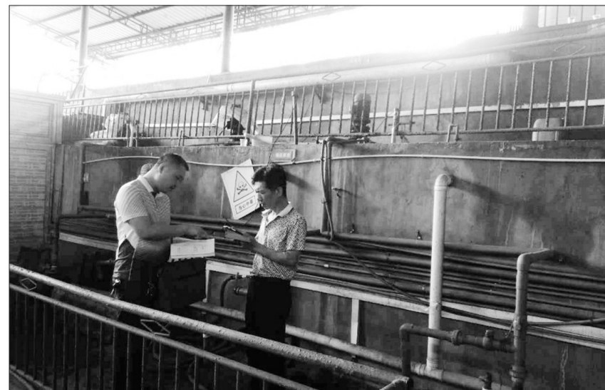
执法人员在检查羊古电镀污染治理设施。
