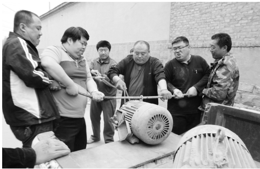
山东省淄博市周村区与滨州市邹平县环保部门建立了跨区域环境污染快速反应协查长效机制。图为两地边界区域一家“土小”企业生产设备正在被拆除。滨州市环境监察支队供图
