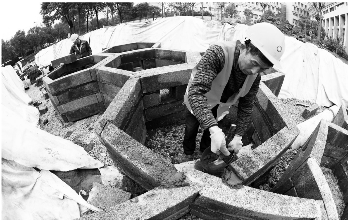
作为全国首批海绵城市建设试点城市之一,四川省遂宁市已开展多项工作。图为环岛商务中心进行“地下蜂窝储水模块系统”施工。 人民图片网
