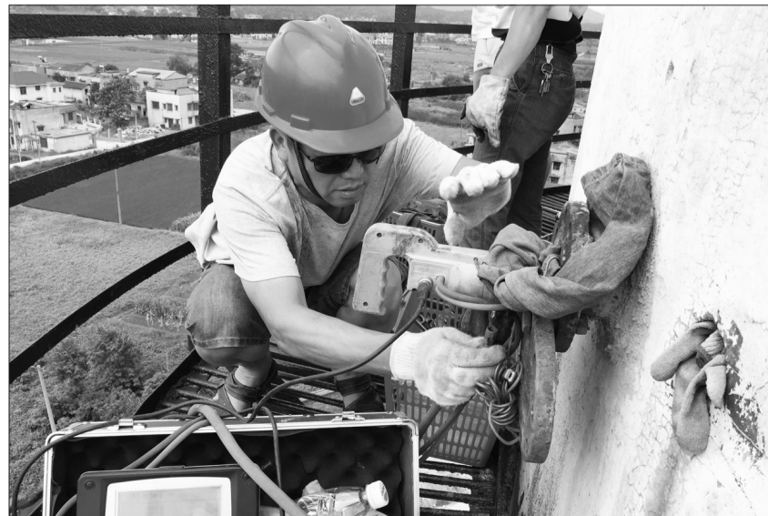
图为环境监测人员正在高空平台上开展废气监测。
