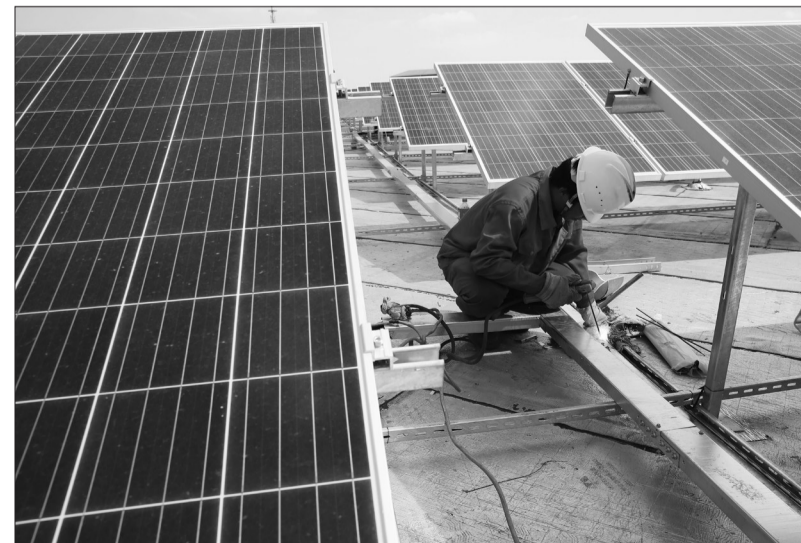
江苏联发纺织股份有限公司积极实施清洁生产,大力利用清洁能源,建设分布式光伏电站,形成屋顶发电,屋里用电的循环格局。目前一期装机容量3MW的分布式电站正在进行调试,预计年发电量可达300万kwh,一年可节省3000多吨标准煤。 人民图片网供图
