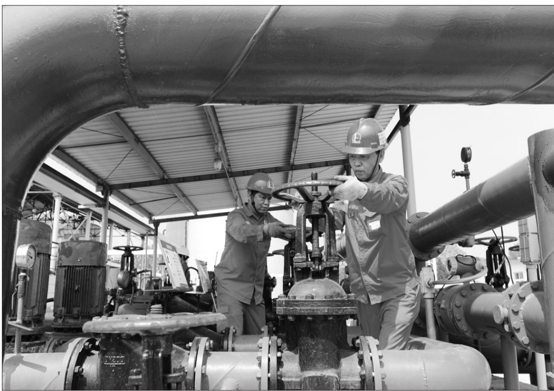
河南油田采油二厂对稠油联合站污水气浮处理工艺进行调整改造,实现污水分质处理。工艺调整后,环保回注气浮装置自主运行,全年可节约污水处理费47万元,减少二氧化碳排放210吨。图为技术人员正在调试污水处理阀门。 胡强摄
