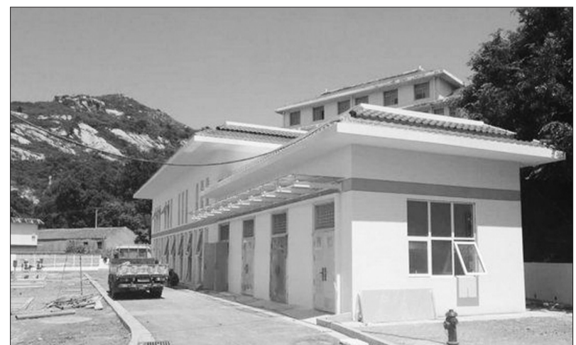
江苏省连云港市连云区在连云岛上新建了一座日处理污水75吨的污水处理站。建成投用后,岛上居民的生活污水和旅游接待产生的商业废水都在这里集中收集,处理后全部用于岛上绿化浇灌。连云污水处理厂投运后,将大大减少对近岸海域水质的污染。
