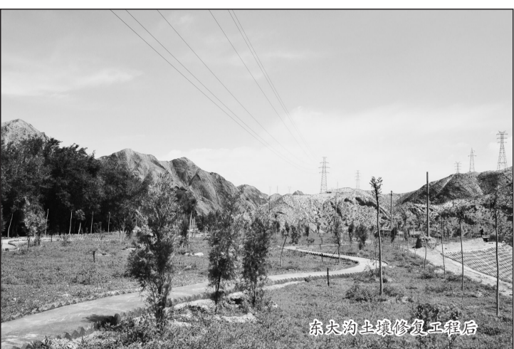
东大沟土壤修复工程后
