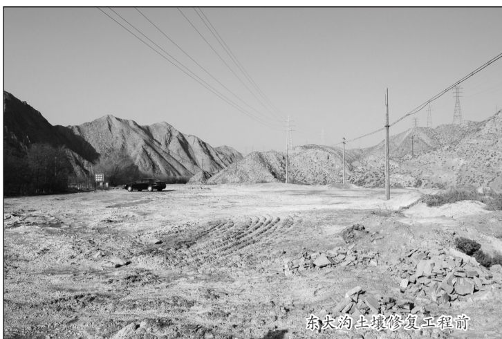
东大沟土壤修复工程前
