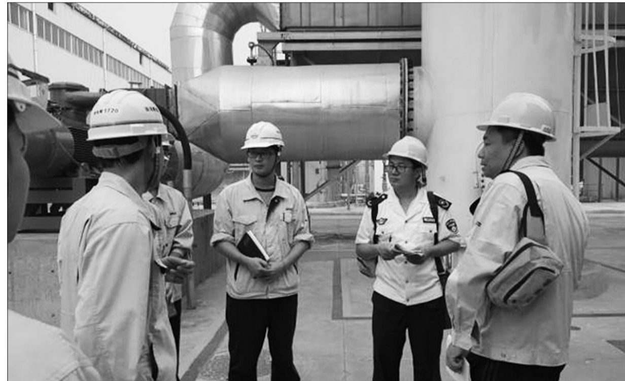
山东省平度市环保局日前邀请化工专家,配合执法人员对新河化工园区企业的环境风险状况逐家进行系统化检查,力求实效对症下药。
