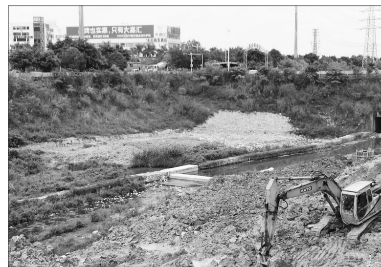
南宁市竹排江上游植物园段(那考河)流域综合整治工程。
