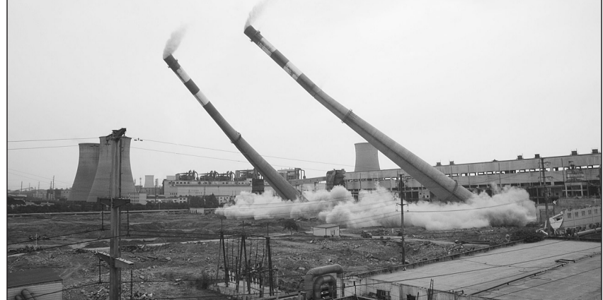
图为山东魏桥创业集团8×60MW热电机组烟囱成功爆破拆除。
