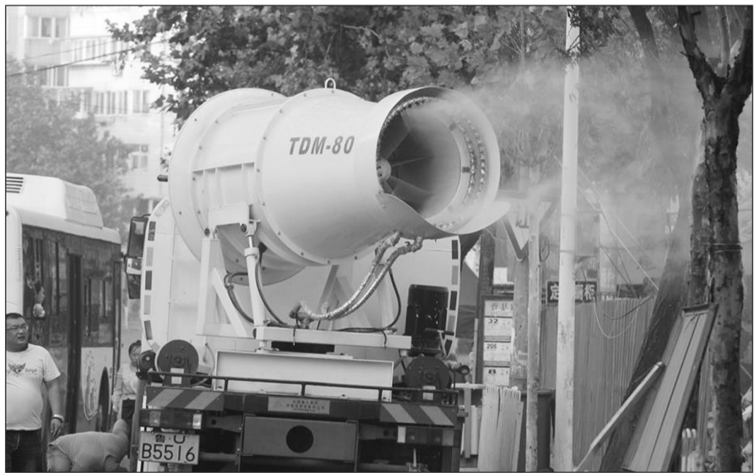
为有效缓解雾霾,近年来,山东省青岛市在易产生扬尘的施工现场广泛使用抑尘车。抑尘车也被称为“雾炮车”,一次能装15立方米水,可连续工作3.5小时~4小时,可喷射60米远的水雾,达到很好的降尘效果。 中国日报图片网供图
