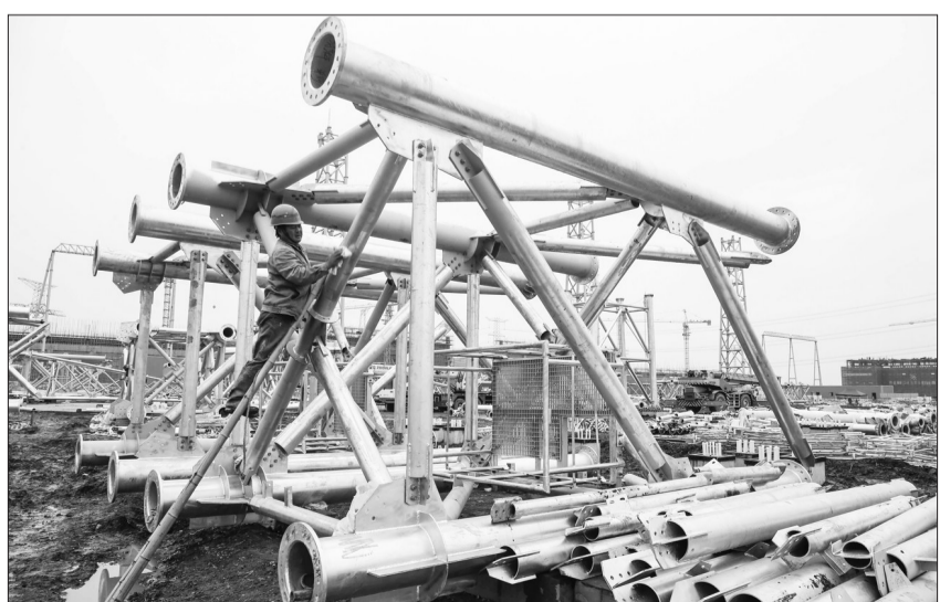
在世界首座交直流混合变电站江苏省泰州变电站,上海送变电工程公司工作人员正在对锡盟—泰州±800千伏特高压直流换流站的21座避雷器构架进行油漆防腐处理。这一工程是世界首座千万千瓦级的特高压直流输电工程,也是国家大气污染防治行动计划“四交四直”特高压工程的重要组成部分。工程起于内蒙古自治区锡林郭勒盟换流站,止于江苏省泰州换流站,途经内蒙古、河北、天津、山东、江苏,全长1620公里。 人民图片网供图
