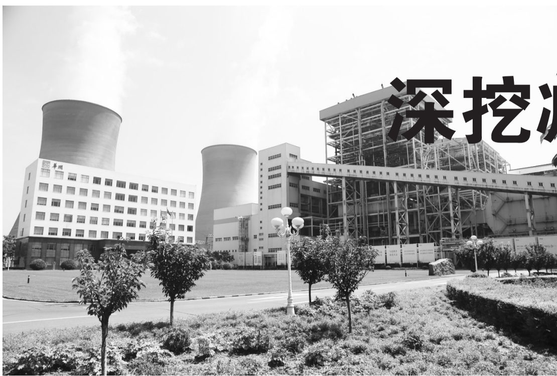
图为河南华润电力首阳山有限公司美丽厂区。
