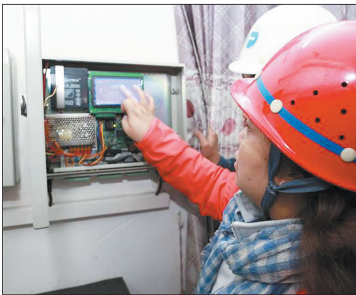
图为督查组成员查看烟气在线监控数据。 本报见习记者熊丹玮摄
