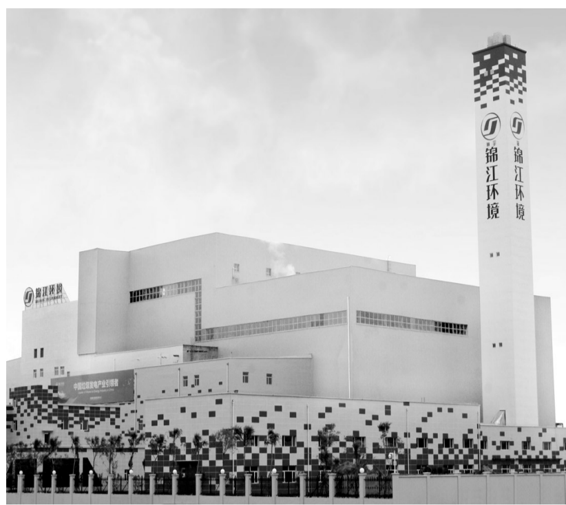
当前地方政府的需求正在发生变化,提出建设静脉产业园。图为锦江环境吉林松原垃圾焚烧发电项目。
