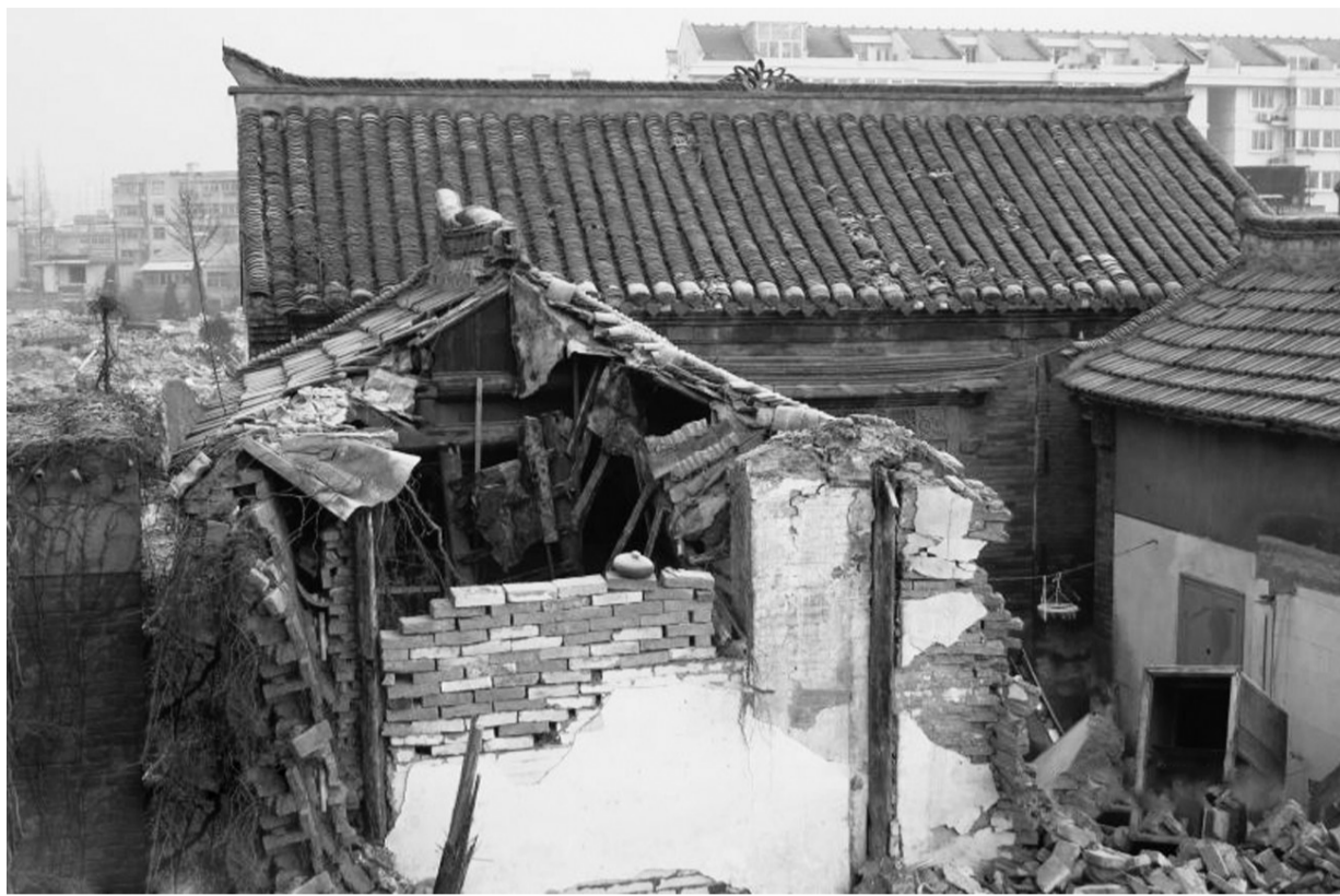
图为江苏省淮安市义顺巷古民居遭到拆迁。
