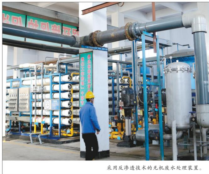
采用反渗透技术的无机废水处理装置。
