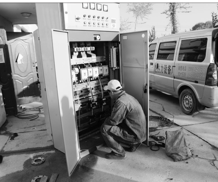
为确保到2017年空气质量明显改善,新疆维吾尔自治区喀什地区巴楚县大力推进大气污染防治工作,在县城区内大面积开展煤改电,年内安装电锅炉35台。图为施工现场。
