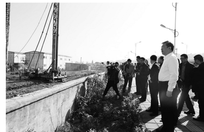
图为佛山市委书记毅带队现场检查工地扬尘污染防治工作。
