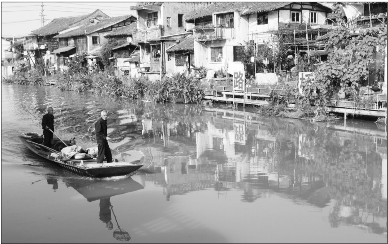
在浙江省台州市路桥区南官河一带,临河而建的砖木结构老房子比较多,考虑到没有施工面,无法在地下铺设管道,路桥区在沿河的河西老街和新路老街都推广了壁挂式污水收集系统,大大提升了南官河的水质。人民图片网供图
