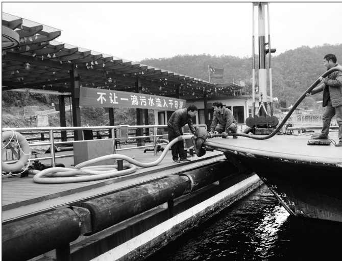
浙江省淳安县努力争创“无污水直排县”,力争不让一滴污水流入千岛湖。自实施“五水共治”以来,淳安县累计收集9.6万吨游船、景点的污水,统一送到岸上污水处理厂集中处理。图为环卫工人将游船上的污水抽送到中转艇船再统一输送到城市污水管网。 杨波 杨韵顺 晏利扬供图
