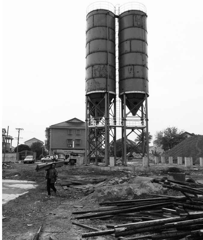
图为已经建成的水泥罐。
