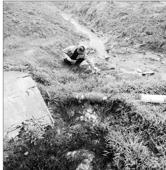
湖南省环保局在执法检查中发现垃圾处理场存在渗滤液未经处理、通过暗管排入外环境等违法行为。图为案发现场。 湖南省环保局供图
