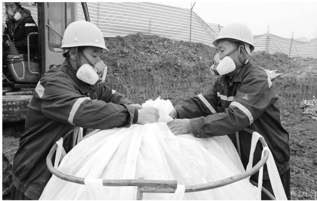
图为公司污染土壤处置现场
