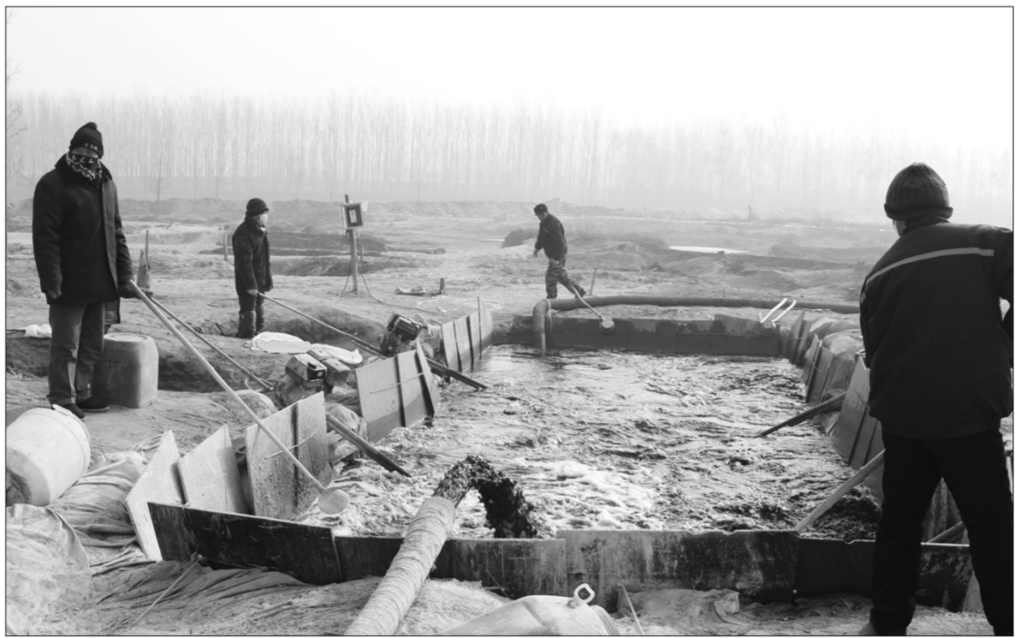
图为滹沱河深泽段治理现场,吸沙泵河流底泥和污水抽到反应池,进行加药处理后,还清的河水重新回到河里。
