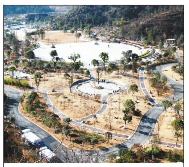
湖北省十堰市通过建设海绵公园、人工湖等雨水滞留和调蓄 工程,让城市具备内涝防治的"海绵"功能。图为四方山生态公园 南门广场,总面积3000多平方米,通过铺设透水砖、种植草坪、建 设蓄水池等,构建了雨水收集系统。储存的雨水基本可以保障喷 泉正常开放和公共绿地灌溉的用水需求。 薛乐生摄
