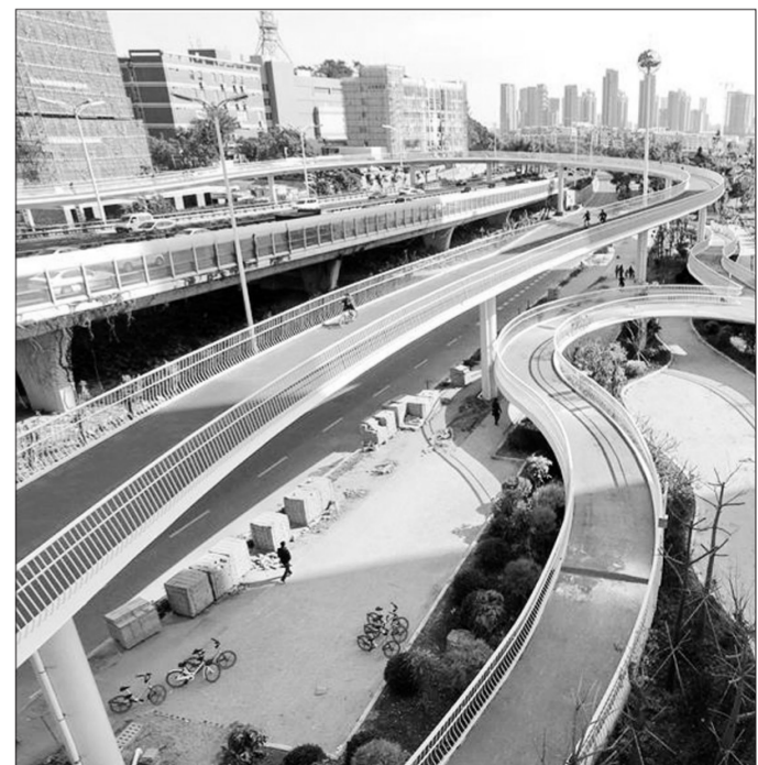
全国首条空中自行车道——福建省厦门市云顶路自行车快速道示范段近日试运营。这条全程高架的空中自行车道全长7.6公里,试运营以来吸引众多市民前来骑行体验,感受“空中骑行”的独特魅力。新华社供图
