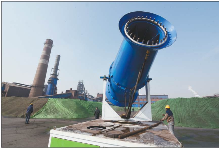
襄汾县新金山特钢有限公司工人正在料场调试除尘装置,督查组要求工矿企业应加强物流运输扬尘治理,加快原料库、堆料场密封改造工程,提高脱硫脱硝除尘等污染治理设施运行管理水平。
