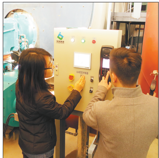
2月23日,北汽福田公司欧辉客车北京工厂的5台燃气锅炉进行低氮改造,技术人员正在调试设备。2017年10月底前,北京市要完成1万蒸吨禁燃区内燃气(油)锅炉低氮燃烧技术改造。 本报记者邓佳摄
