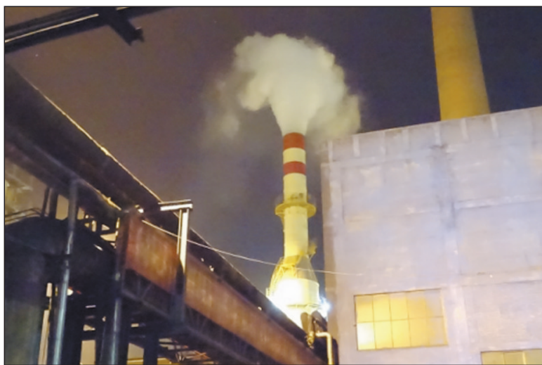
河北金源化工股份有限公司“三废炉”无脱硝设施。环境保护部供图
