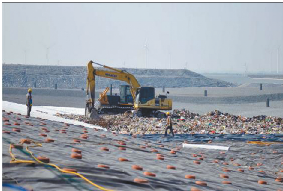
上海老港基地四期生活垃圾填埋场。资料图片
