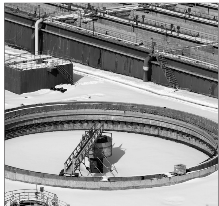
新疆维吾尔自治区乌鲁木齐市新建成一家污水处理厂,日处理能力可达7.5万立方米。这家污水处理厂在处理过程中,通过新工艺,利用一种可以吸收污水中“营养物质”的细菌,除去臭味,处理后的出水可用于厂区及周边小区的绿化。
