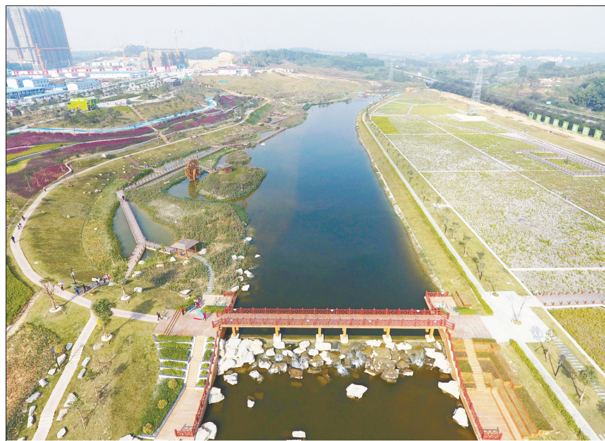
那考河是广西壮族自治区南宁市内河竹排江上游两大支流之一,之前水质常年为劣V类,极大地影响了下游竹排江、南湖的水质。通过一年多的综合整治,那考河从臭水沟变成了美丽的湿地公园。 新华社供图/周华摄
