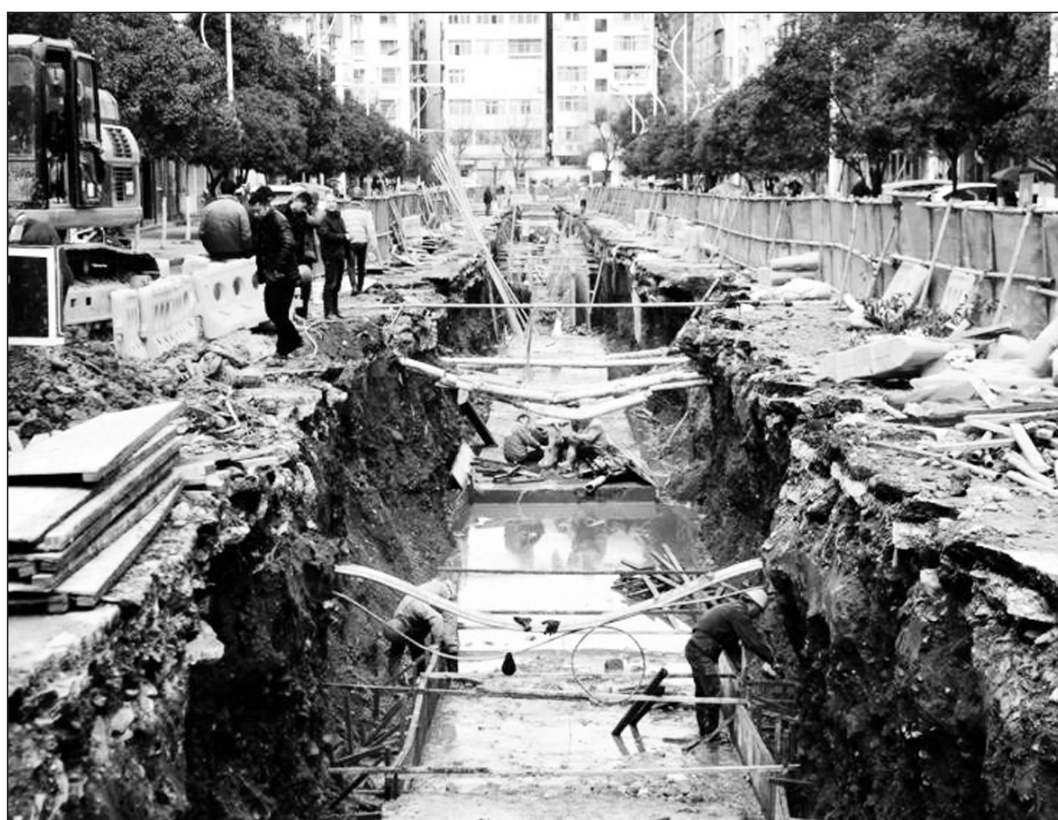
玉虚路商业步行街建设是湖北省十堰市武当山特区城区综合整治的主要项目之一,按照生态修复与城市建设并行的思路,玉虚路商业步行街预计于4月底完成3.2千米范围内的管网改造、风情带建设、绿化美化亮化等工作。
