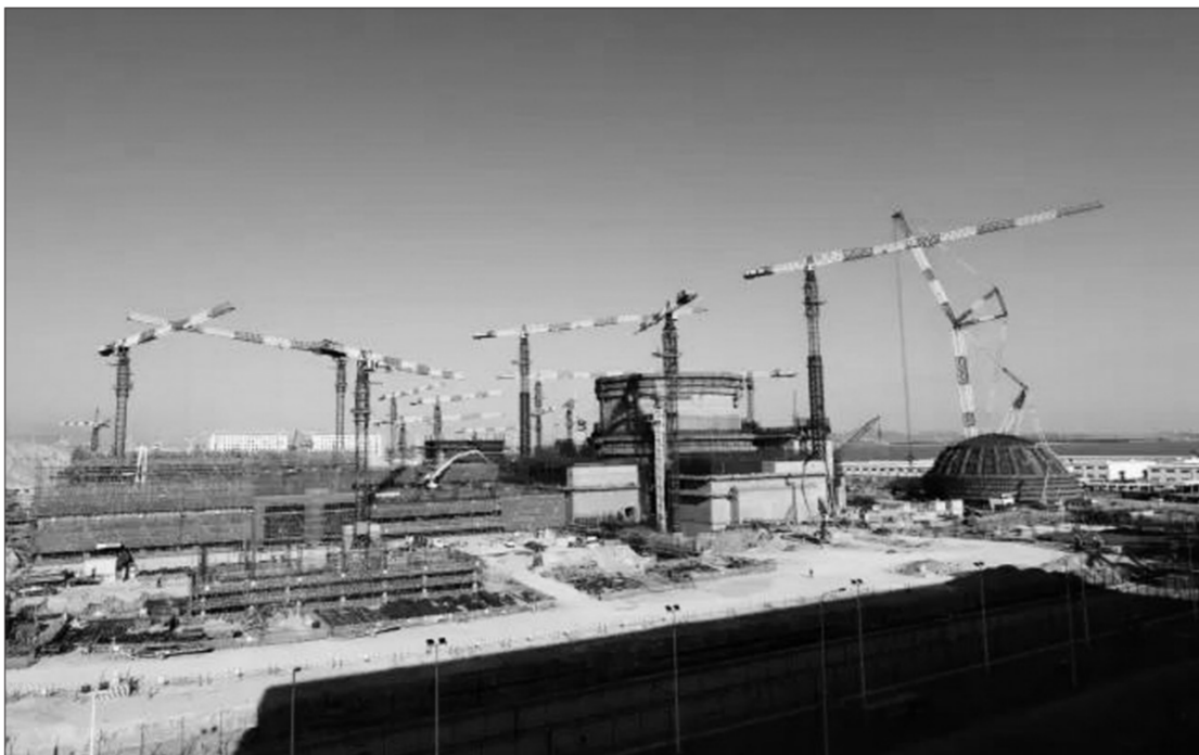
图为中国自主三代核电技术“华龙一号”示范工程——福清5号核电机组施工现场。
