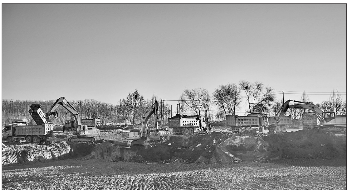
北京市朝阳区萧太后河马家湾段施工现场。
