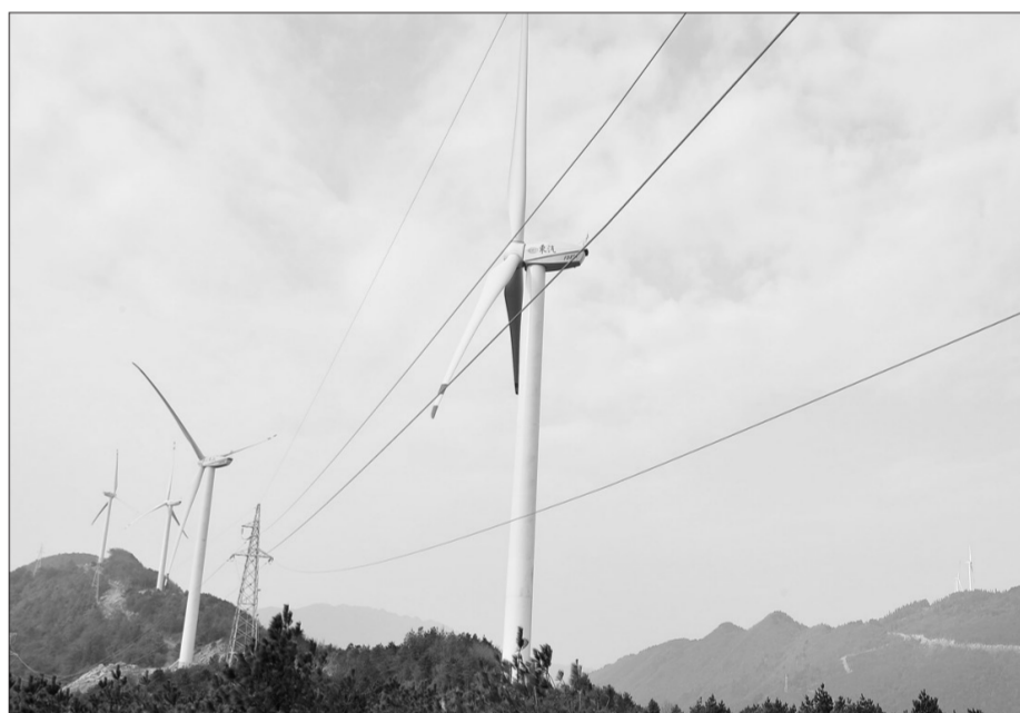
四川省广元市朝天区西北乡、蒲家乡境内的大唐广元芳地坪风电场是四川省首个山地风电场。截至2017年2月底,这个风电场已累计发电11099.85万千瓦时,减排二氧化碳10.83万吨,减排二氧化硫824.87吨,减排氮氧化物708.22吨;产值约6770万元,税收近984万元。张厚美 张玉洁摄
