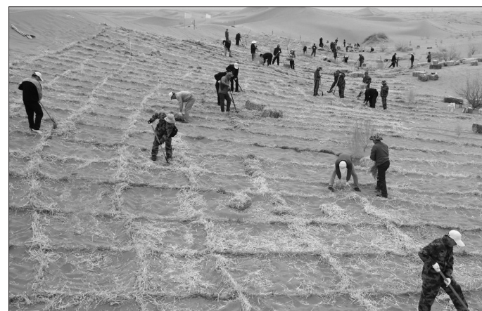
甘肃省临泽县位于巴丹吉林沙漠边缘,沙漠戈壁面积占到全县总面积的2/3以上。多年来,当地采取多种措施从源头上阻止生态环境恶化。图为当地群众用麦草筑筑阻沙网。
