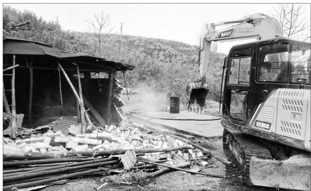
图为拆除非法作坊厂房仓库现场。
