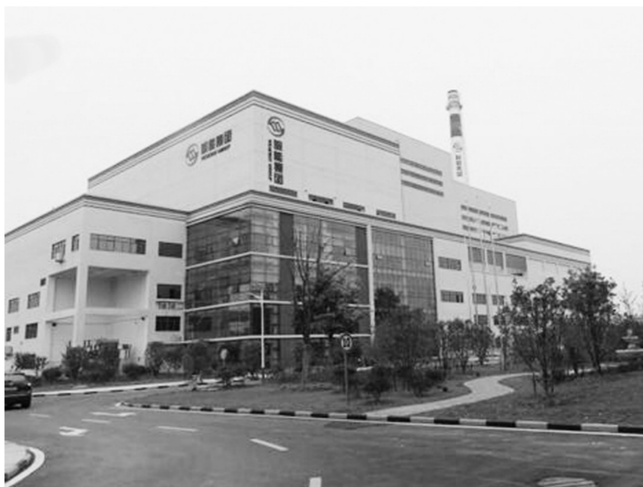
●北京利用水泥窑协同处置1吨飞灰约1500元,按照1吨垃圾产生2.5%的飞灰计算,吨垃圾飞灰处置近40元;采用整合剂加水泥固化的成本在600元~900元。
