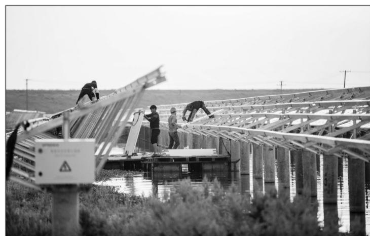
位于鄱阳湖畔的江西省都昌县瓦窑湖“渔光一体”光伏项目近日在加紧安装,预计今年5月可建成投产。这一项目利用瓦窑湖水产市场部分保水保肥能力差的沙质鱼池,架设光伏板进行光伏发电,实行水上发电、水下养鱼的模式,提高水面资源利用效率。 人民图片网供图
