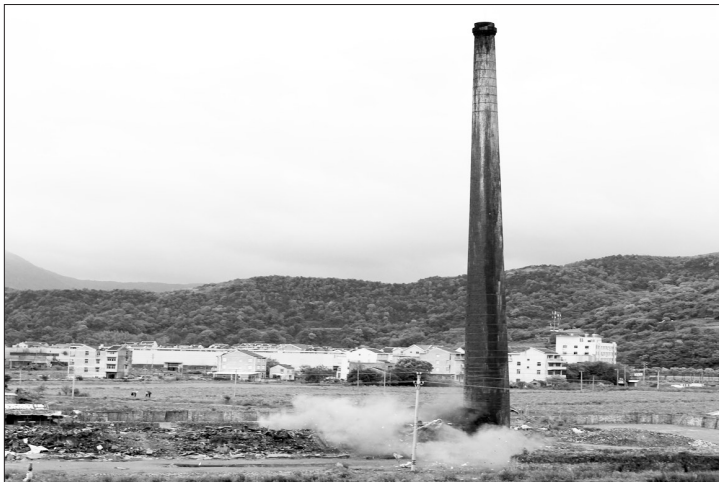
浙江省温岭市城南镇近日对位于温岭国庆塘拆迁红线范围内的最后一家高污染土砖窑厂的窑芯进行了定向爆破。 人民图片网供图
