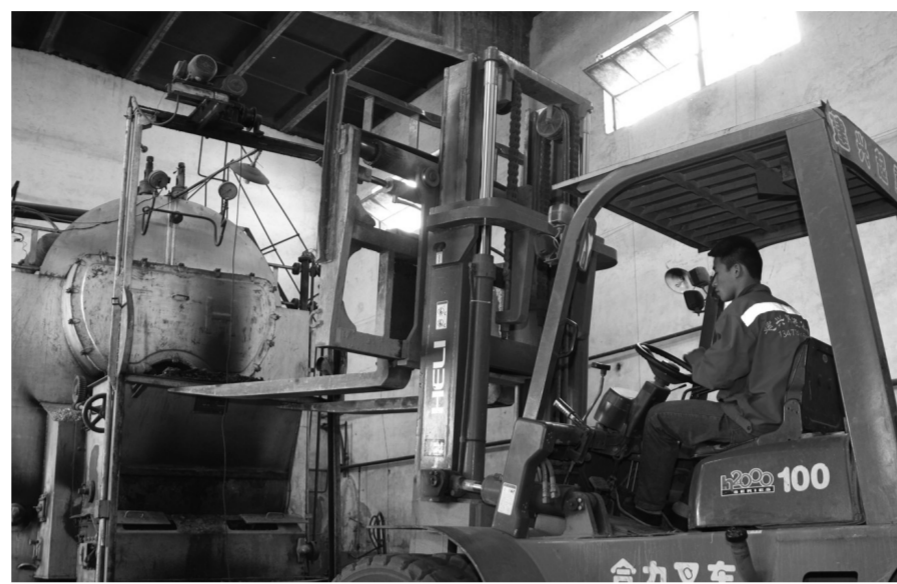
今年以来,石家庄启动了燃煤锅炉淘汰专项行动。截至5月19日,全市共淘汰燃煤锅炉3797台、4717.4蒸吨,完成任务的88.4%。图为石家庄市栾城区对淘汰的燃煤锅炉进行切割拆除作业。李玺尧摄
