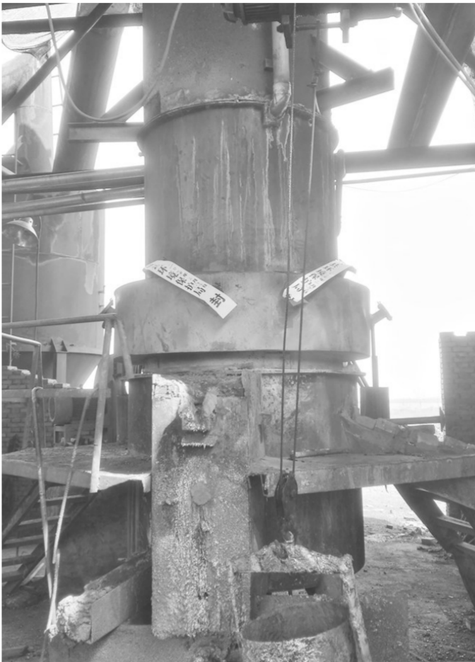
图为陕西省澄城县华友镁业有限公司废弃厂房非法冶炼炉窑堵堵现场。 陈晓民摄
